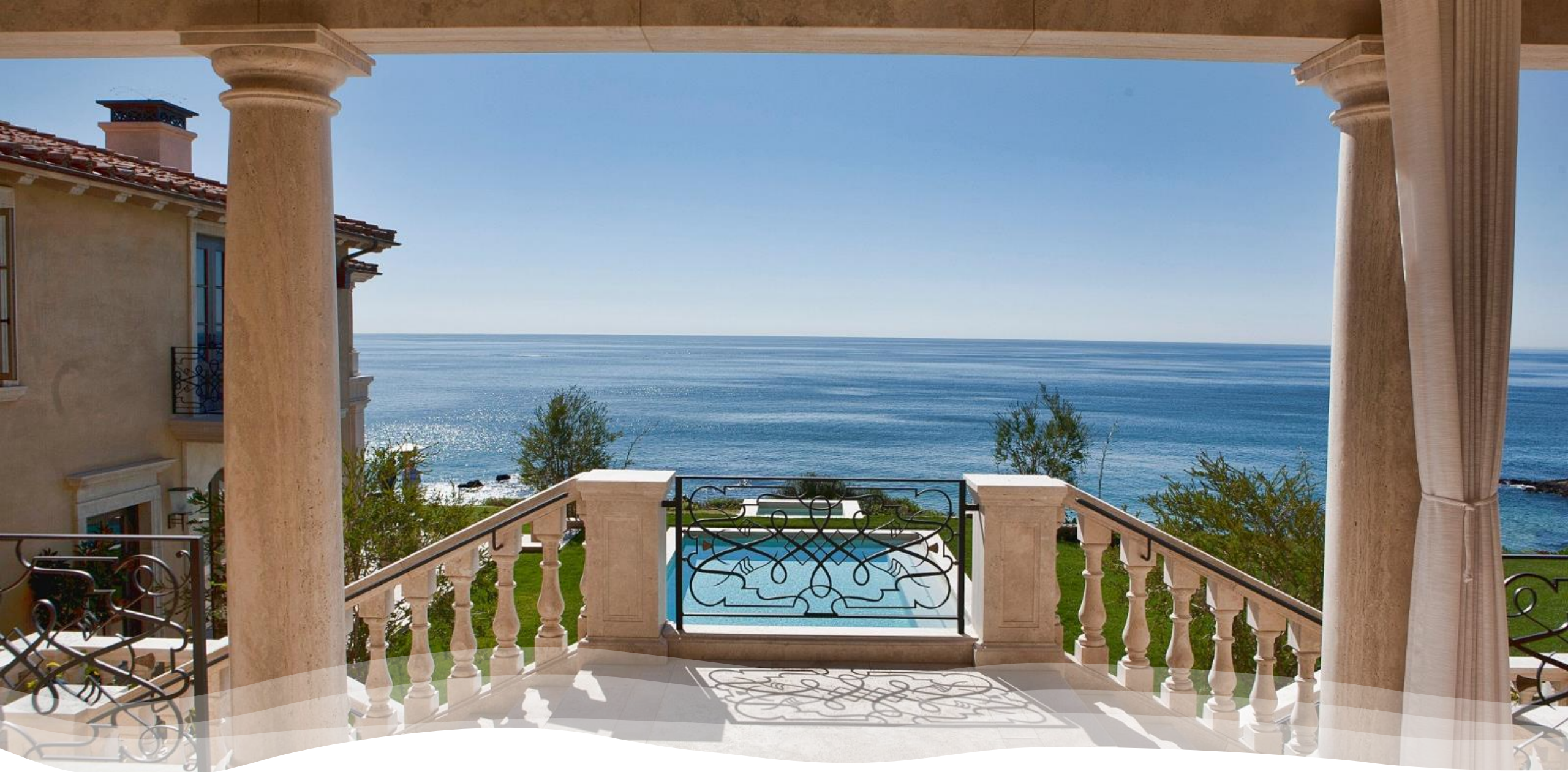
Realizzazione patio esterno
