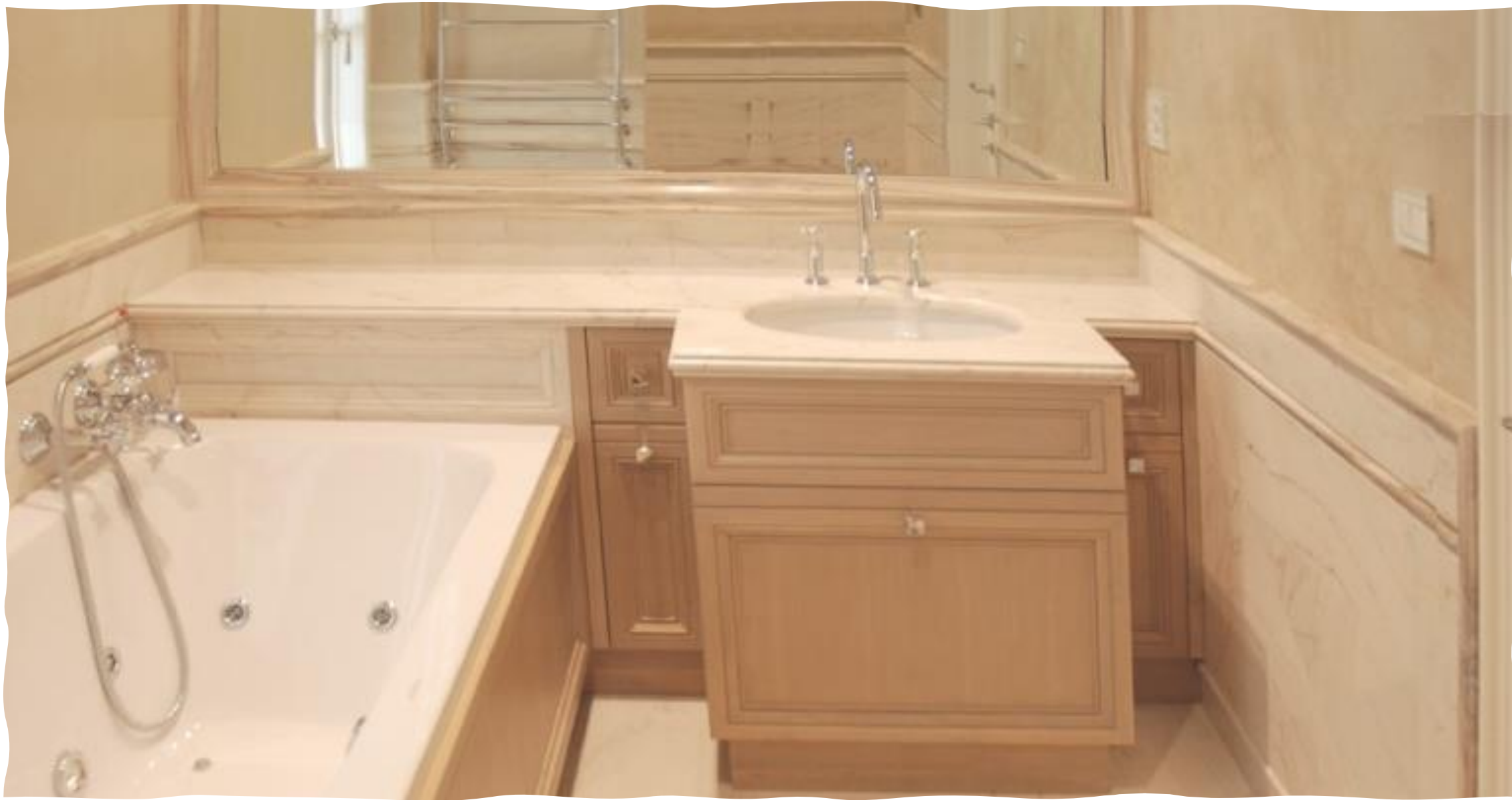
Realizzazione pavimento, rivestimento e top bagno in marmo
