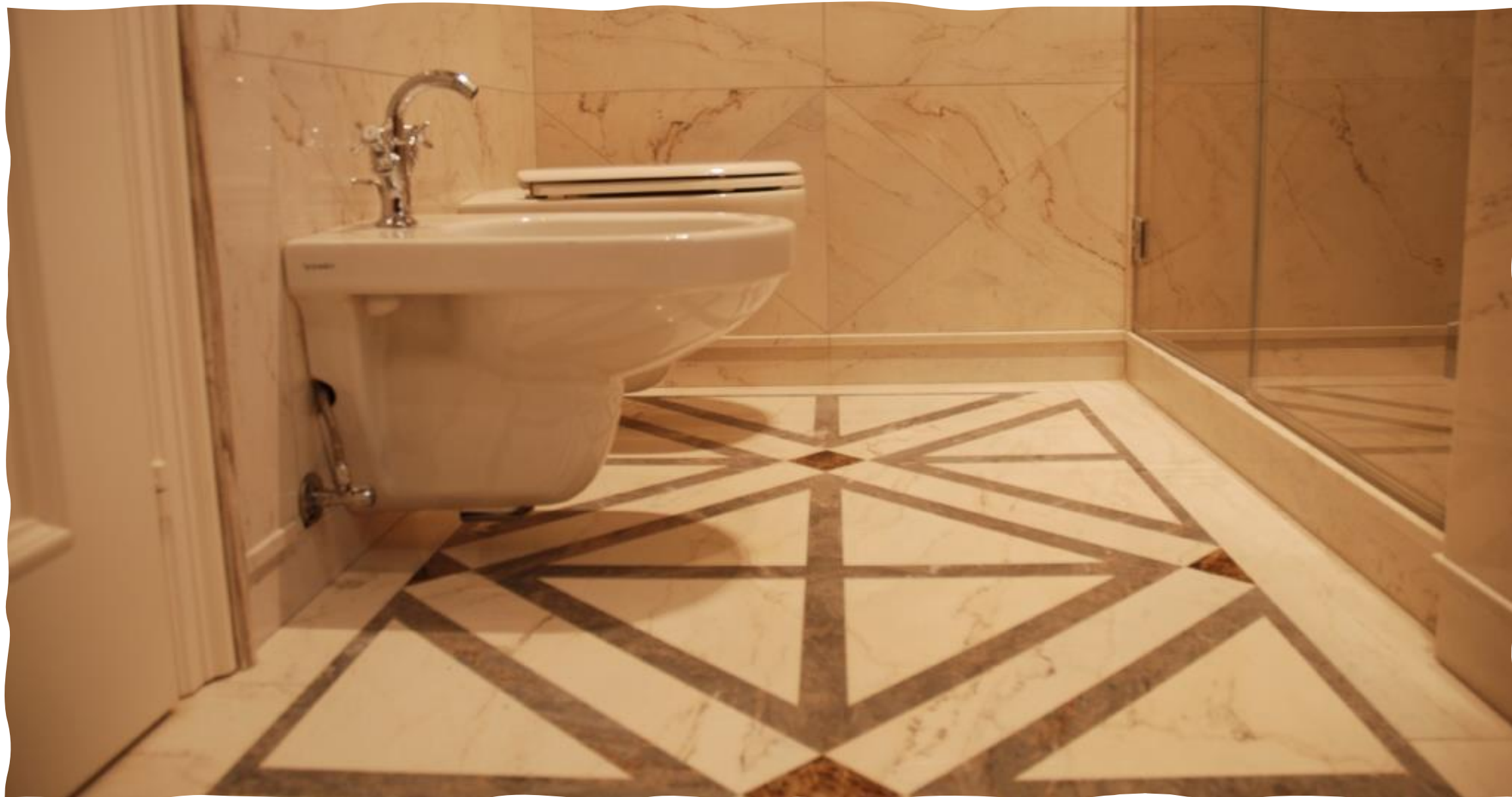
Realizzazione pavimentazione e rivestimento bagno in marmo
