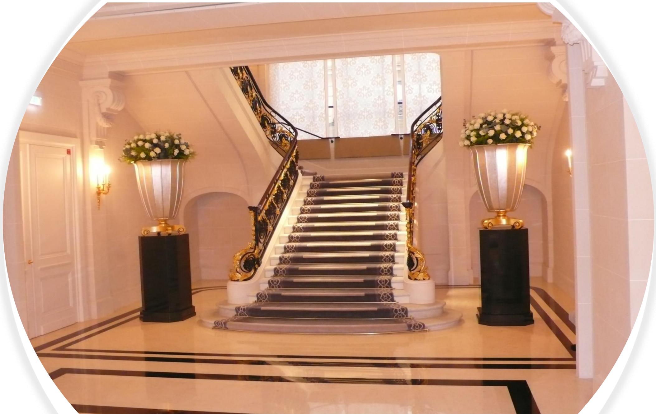
Realizzazione scala e pavimentazione in marmo
